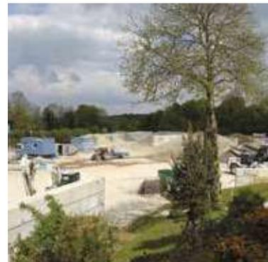
Implantée depuis 20 ans sur le pays de Quimper, Yprema réceptionne les bétons de déconstruction pour les transformer en produits destinés aux chantiers du BTP. Concassé, criblé, le béton est recyclé en matériaux offrant aux entreprises de travaux publics des solutions respectueuses de l'environnement : Grave Concassée Industrielle et Grave de Béton Concassé.
